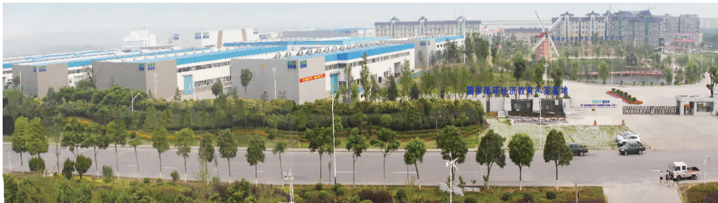
湖北荆门格林美城市矿产资源循环产业园(南北区)
