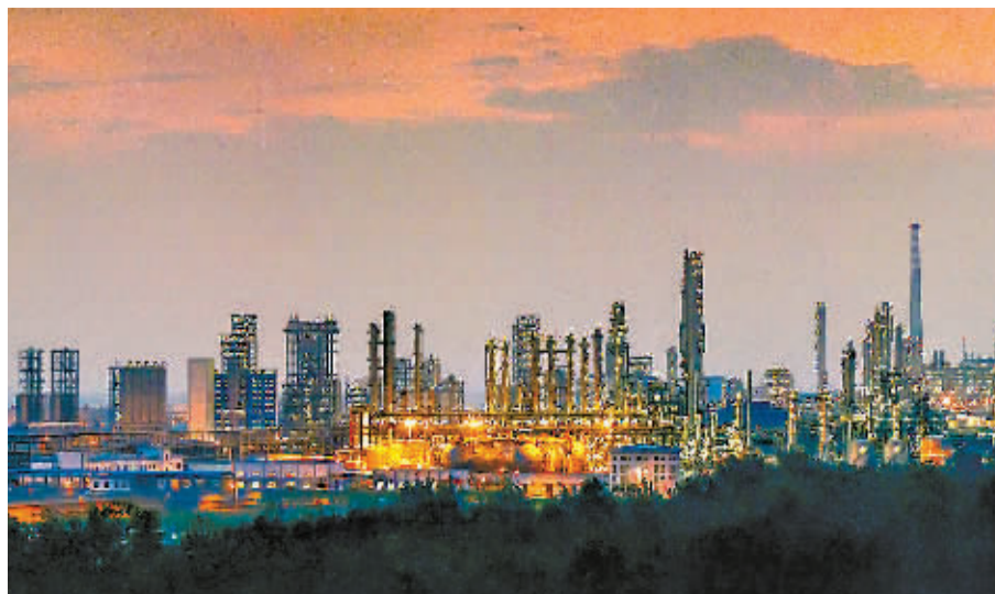
乙烯远眺 站在阳逻长江大桥拍摄的80万吨乙烯工程 无隅 摄
