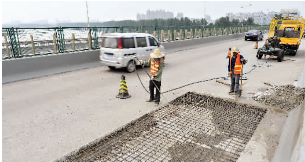
昨日,府河桥围挡施工路段,工人将破损的桥面清理干净后,重新铺上钢筋加固 记者胡冬冬 摄 实习生余博文 信息来源:陈建忠)
