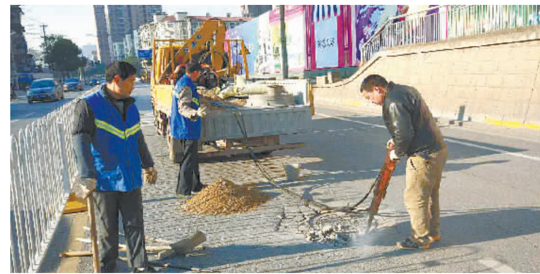
汉阳水务系统工作人员清渠畅排
