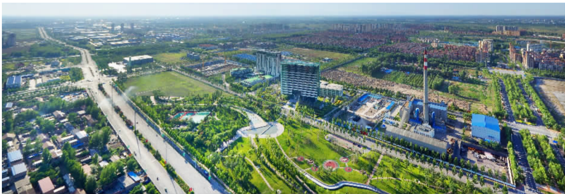
固安产业新城实景图
