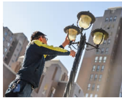
开展设备检修
