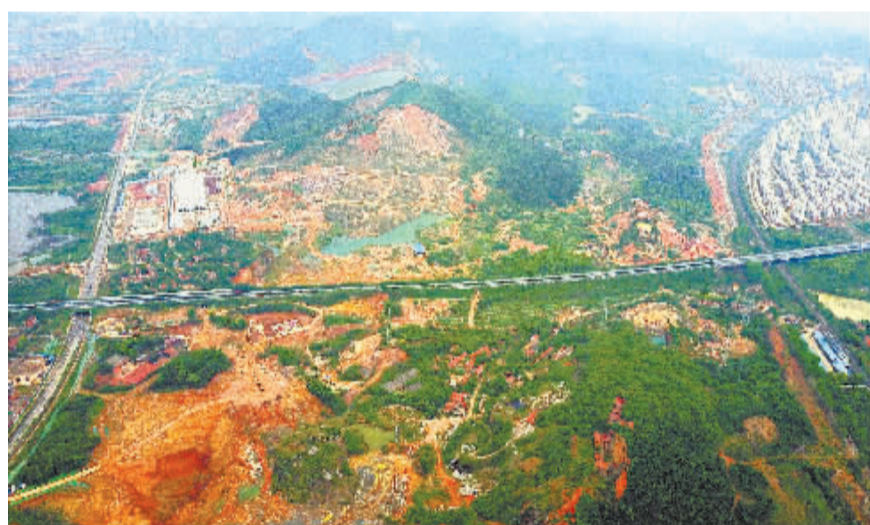
空中俯瞰武汉外环横穿顶冠峰弃土消纳场 记者刘斌 摄 信息来源:凌勇
