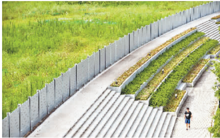
位于流通巷汉江畔的拼装式防洪墙 记者彭年 摄
