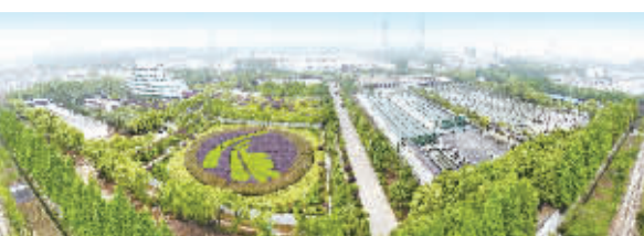
完成三期扩建的沌口水厂
