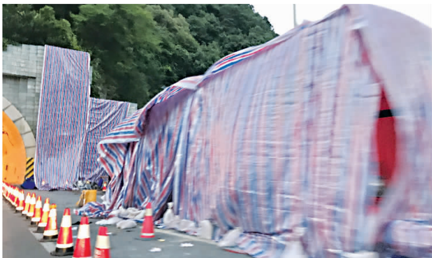
11日19时40分,现场已恢复通畅,红色客车和被撞墙壁一起被彩料布包裹,但依然能透过周围散落的杂物看出事故的惨烈。客车左侧的地面虚线上摆放有贴着荧光标志的塑料桶,隔离事故车辆,也提醒着过往车辆
