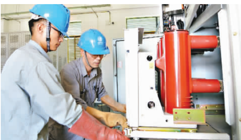
电力工人在凤凰镇为企业架设供电专线 通讯员吴毅 摄
