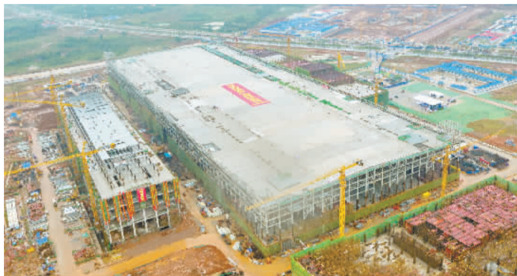
28日,国家存储器基地项目(一期)一号生产及动力厂房在东湖高新区成功封顶,比预定时间提前一个月 记者胡九思 摄
