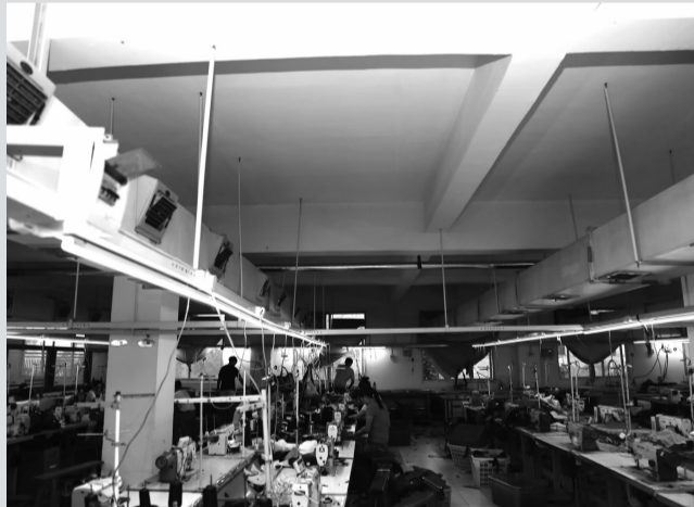
永丰街四台工业园服装厂内空间密闭,易燃物堆放杂乱
