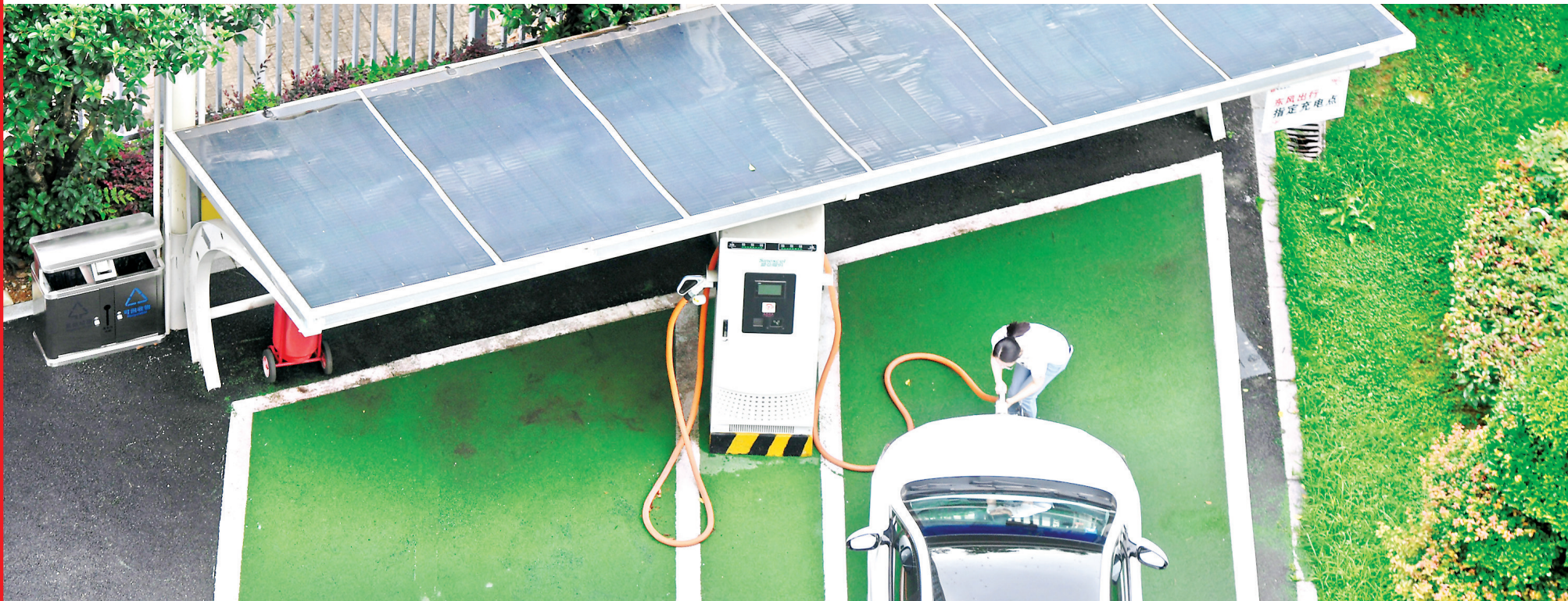
市民在“光储充”一体充电站充电,顶棚就是光伏发电设备。周超 摄
