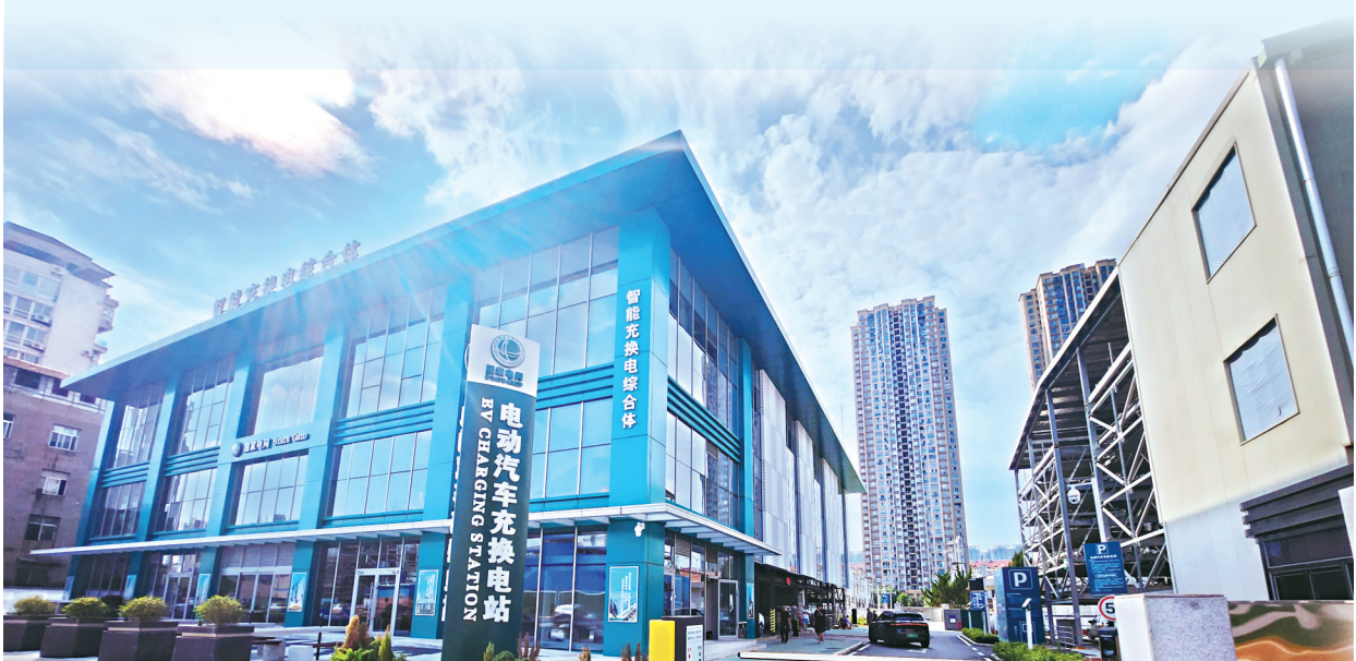
汉口火车站西侧的智能充换电综合体,建有212个充电车位。
