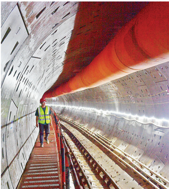
地铁12号线丁家咀站至十里铺站区间右线穿越硬岩段隧道内部。 李永刚 摄
