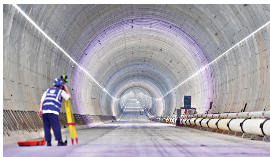
“江城先锋号”盾构机建造出一条深埋江底的大型隧道。
