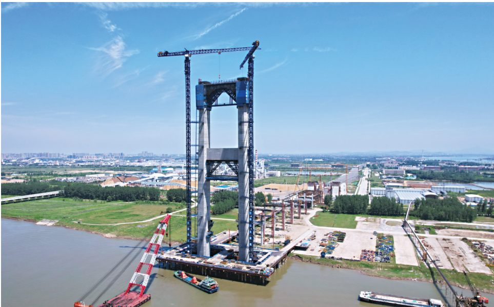
燕矶长江大桥北主塔正24小时施工,预计6月底可封顶。 通讯员徐颖 摄
