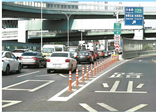
匝道口隔离柱,让车道分流更有序。
