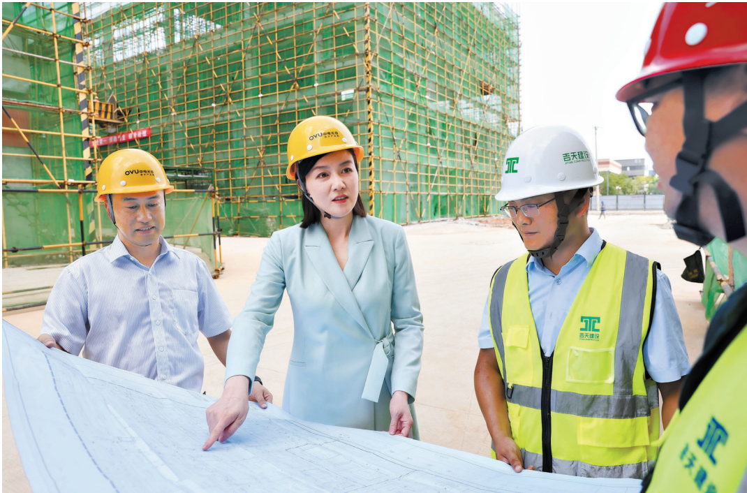
6月13日，黄黎（左二）在中电光谷数字产业园二期项目建设现场讨论工程最新进展。
