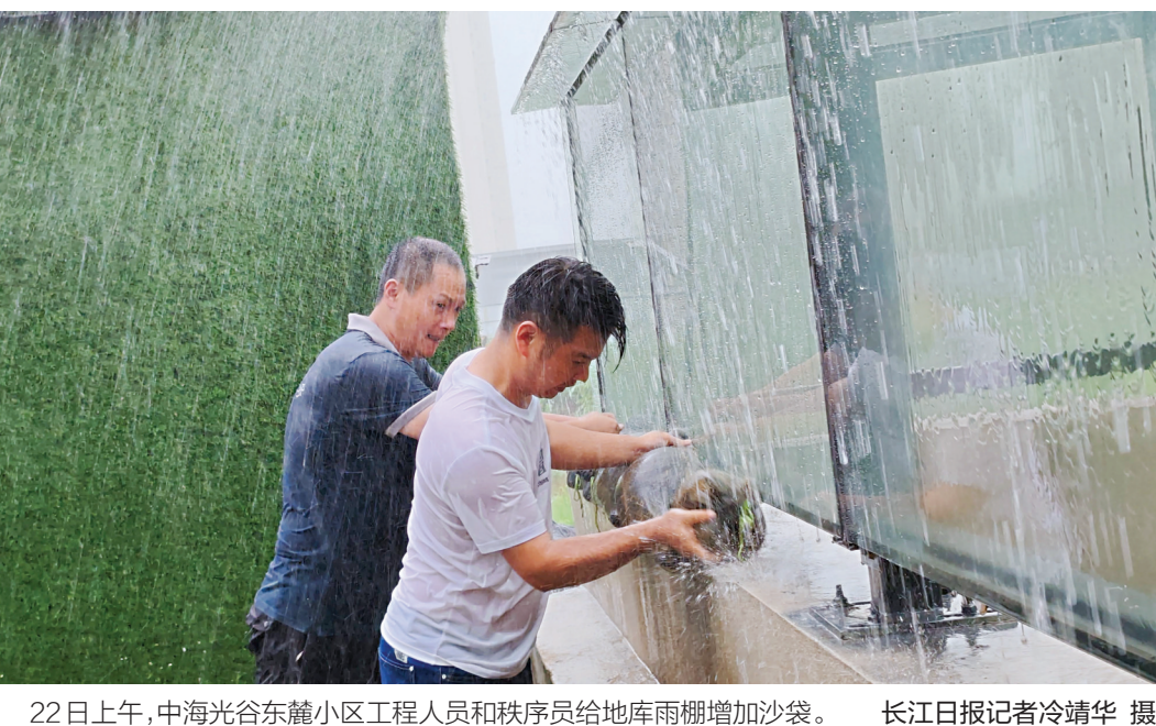
22日上午,中海光谷东麓小区工程人员和秩序员给地库雨棚增加沙袋。 长江日报记者冷靖华 摄
