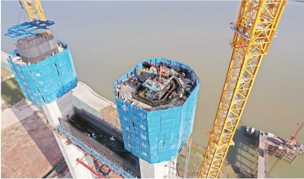
新港双柳长江大桥项目北主塔施工现场。
