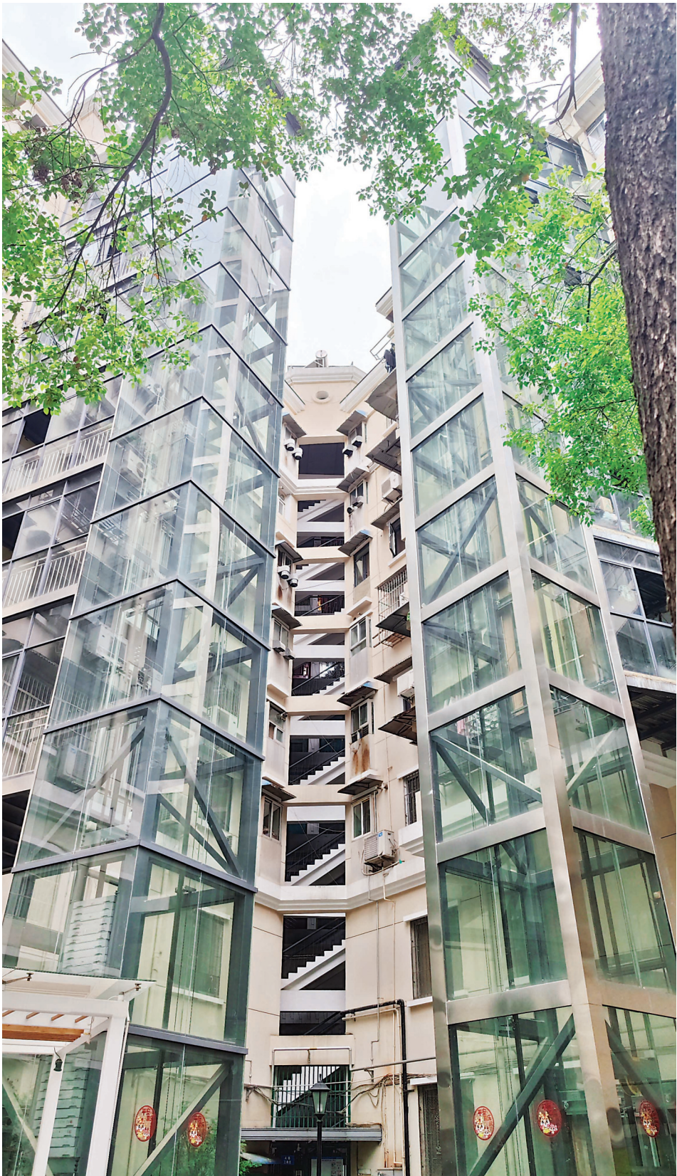
安友花园小区加装的电梯。
