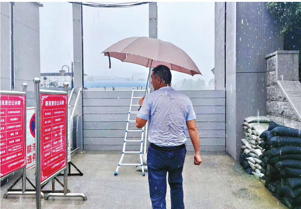
7月1日下午2时,硚口区邱家档闸口,水务工作人员雨中巡查拼装式防洪墙。
