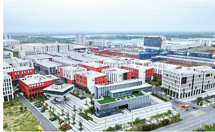
中电光谷智造中心项目。
