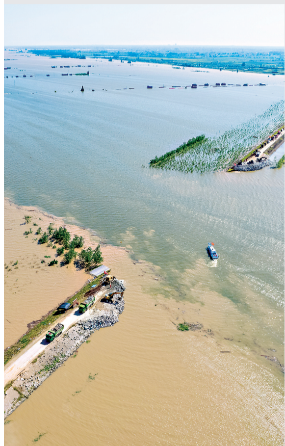
6日,抢险队伍在进行堵口作业(无人机照片)。
