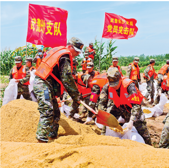
7月8日，武警湖南总队长沙支队官兵在湖南省岳阳市团洲垸钱团间堤装填搬运沙袋封堵管涌。 新华社发
