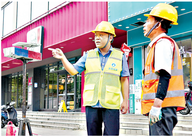
武昌阅马场街头,龚颖(左)现场指导周边人行道的维修施工。 长江日报记者何晓刚 摄
