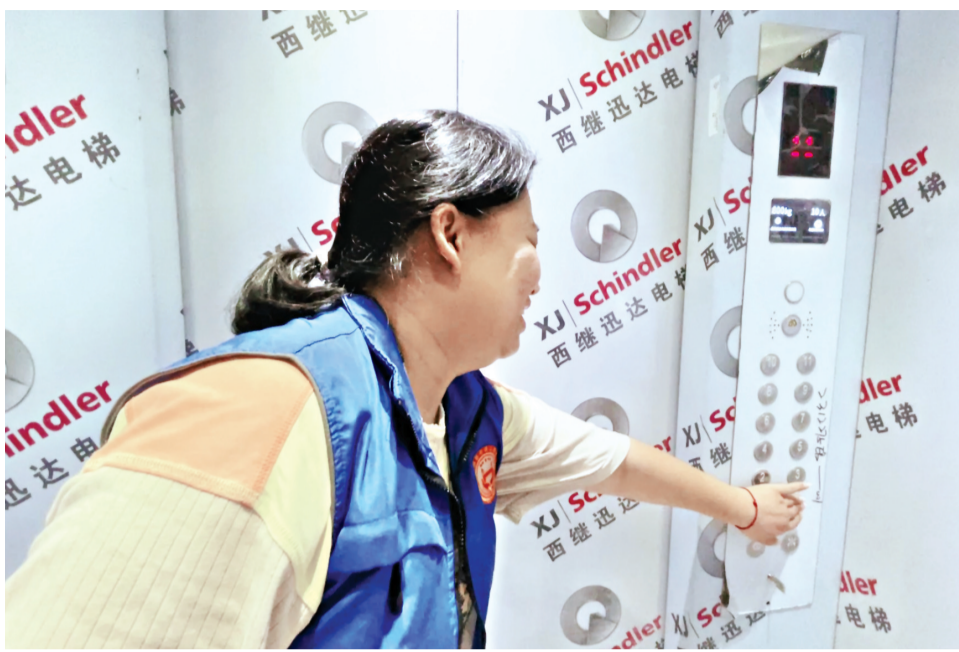
B栋4单元的新电梯正在试运行。
