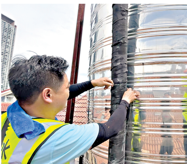
7月16日下午,维修人员用铁丝固定进水管位置,把进水管与水箱捆绑在一起,避免进水时水管撞击水箱发出噪声。
