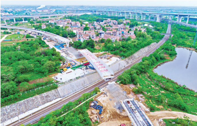
前川线二期工程桥梁转体。
