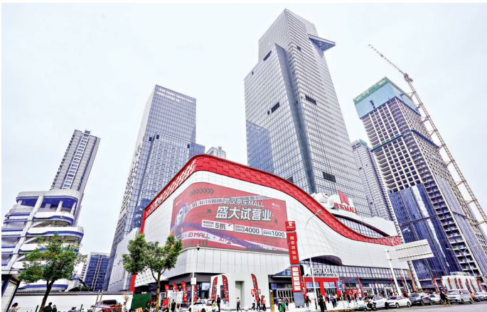
华中首家京东MALL 位于地铁秦园路项目。
