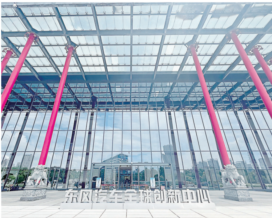
“红柱子大楼”曾是武汉经开区管委会办公大楼,现在成为东风汽车全球创新中心。长江日报记者汪文汉 摄
