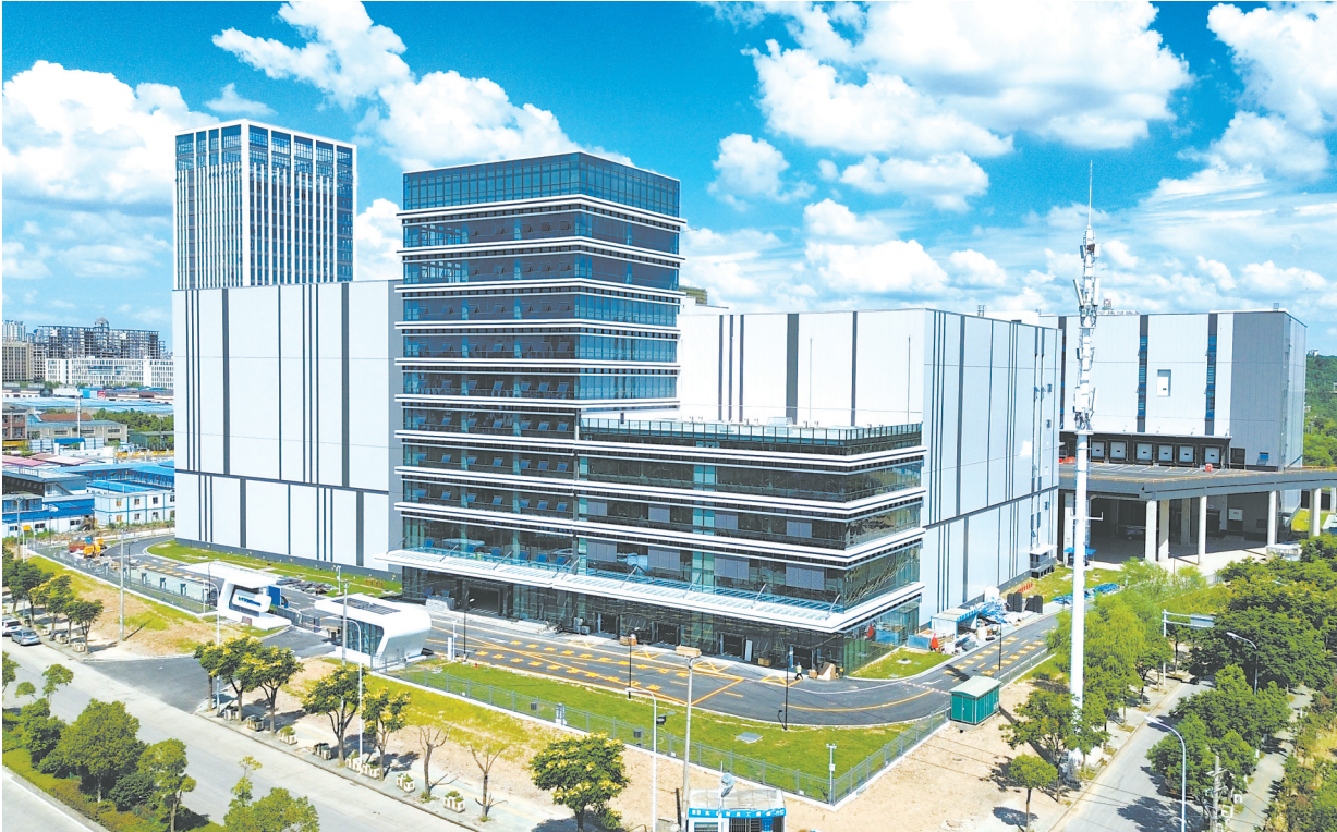
武汉主城区规模最大的冷链仓储项目竣工。
