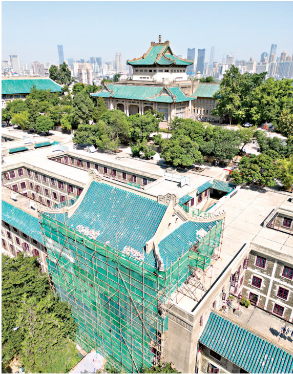
武汉大学樱园学生宿舍楼顶阁楼屋面琉璃瓦修复现场。长江日报记者詹松 摄
