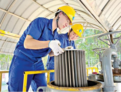
运维工小心地提出天然气过滤器中的滤芯,再换上提前清洗好的干净滤芯,全过程要求严丝合缝。
