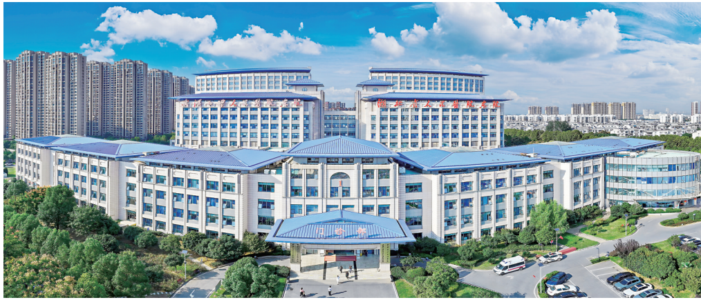
东院区(光谷院区)。
