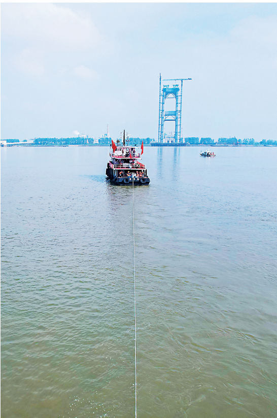
拖轮拽拉先导索从南主塔向北主塔驶去。
