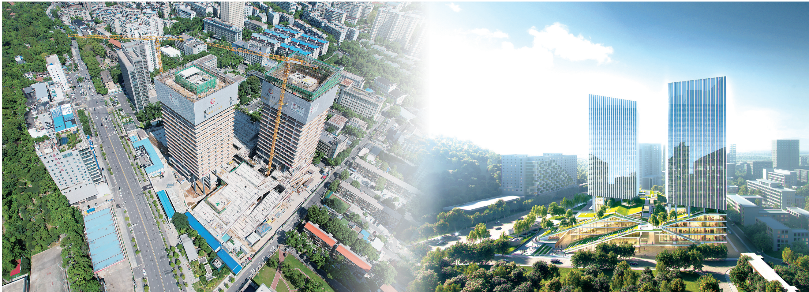
小洪山科学城项目正火热建设中。
