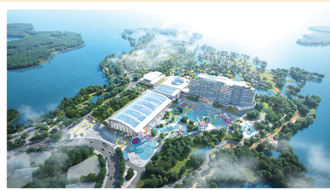
武汉城建·中法半岛水世界主体结构完工，预计明年对外开放。
