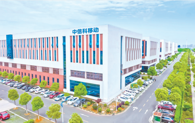
中信科移动大楼。
