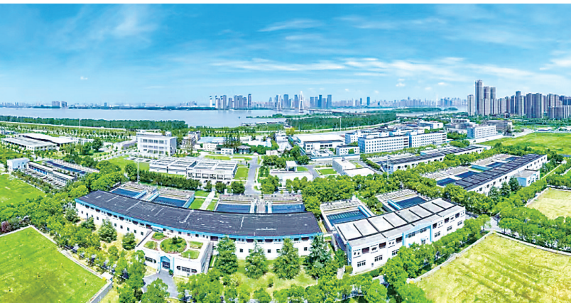
武汉城投水务集团白沙洲水厂。
