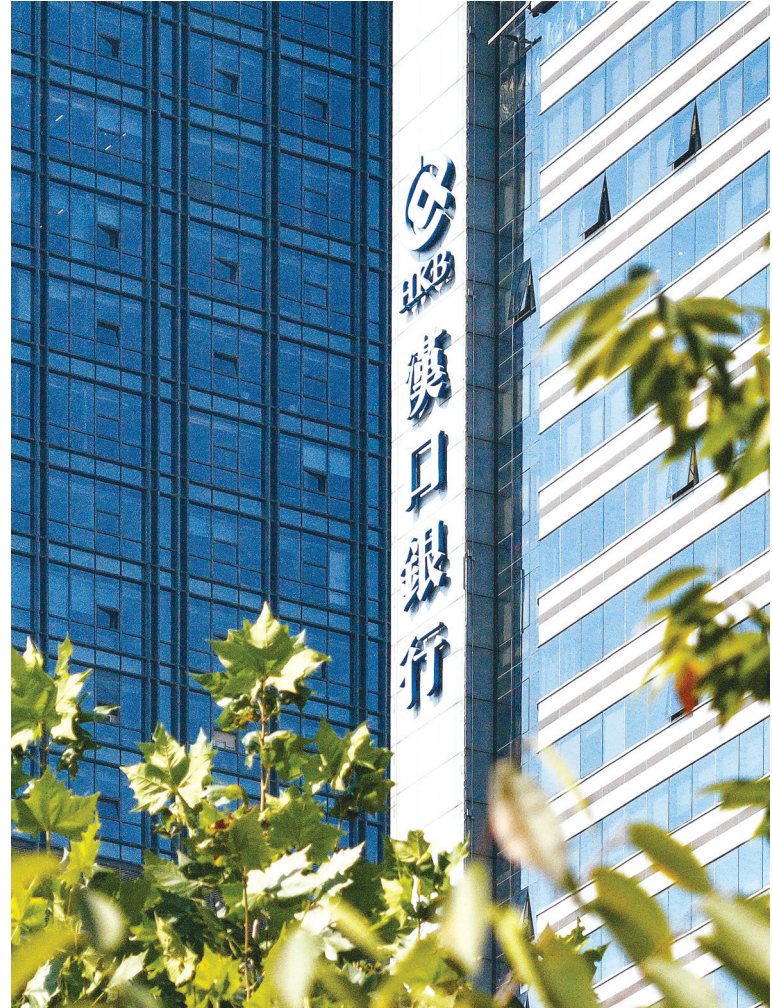
汉口银行大楼。
