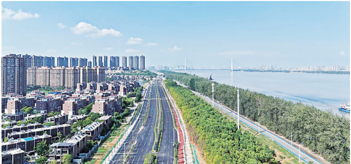
长江主桥左岸大道打通军山新城长江沿江综合发展轴的关键交通动脉。
