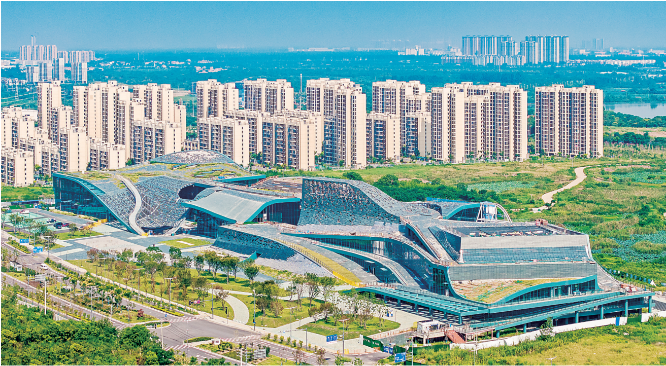
中法生态城文化体育中心作为中国绿色建筑三星和法国HQE双认证项目，以先进的生态、环保、节能技术竖起武汉绿色建筑新标杆。
