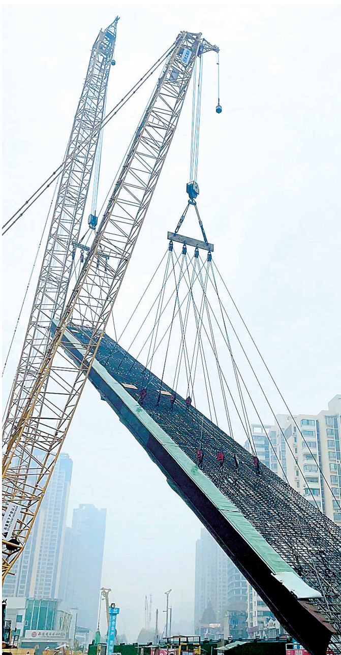
武汉地铁12号线太平洋站最后的地连墙钢筋笼完成吊装。 通讯员郑军 摄
