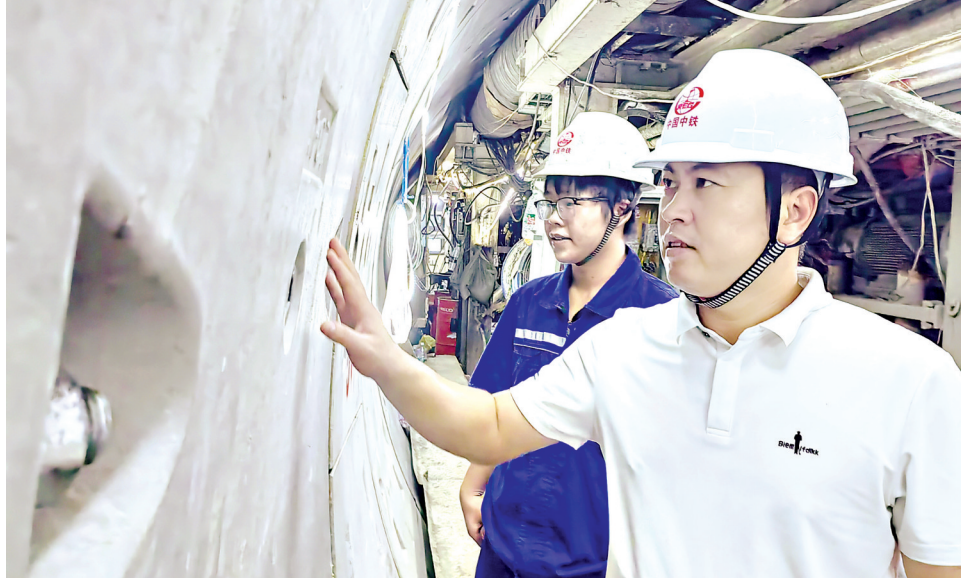
地铁12号线四四区间施工人员检查管片拼装质量。
