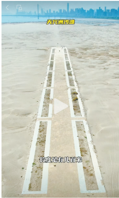
长江日报记者汪洋 摄 网友拍摄的天兴洲航道整治工程露出江面的部分。
