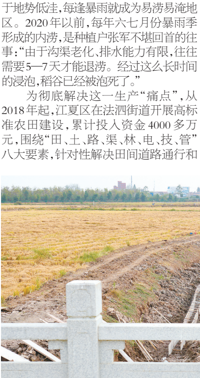
江夏区法泗街道八塘村高标准农田正在排水主渠硬化建设中。
