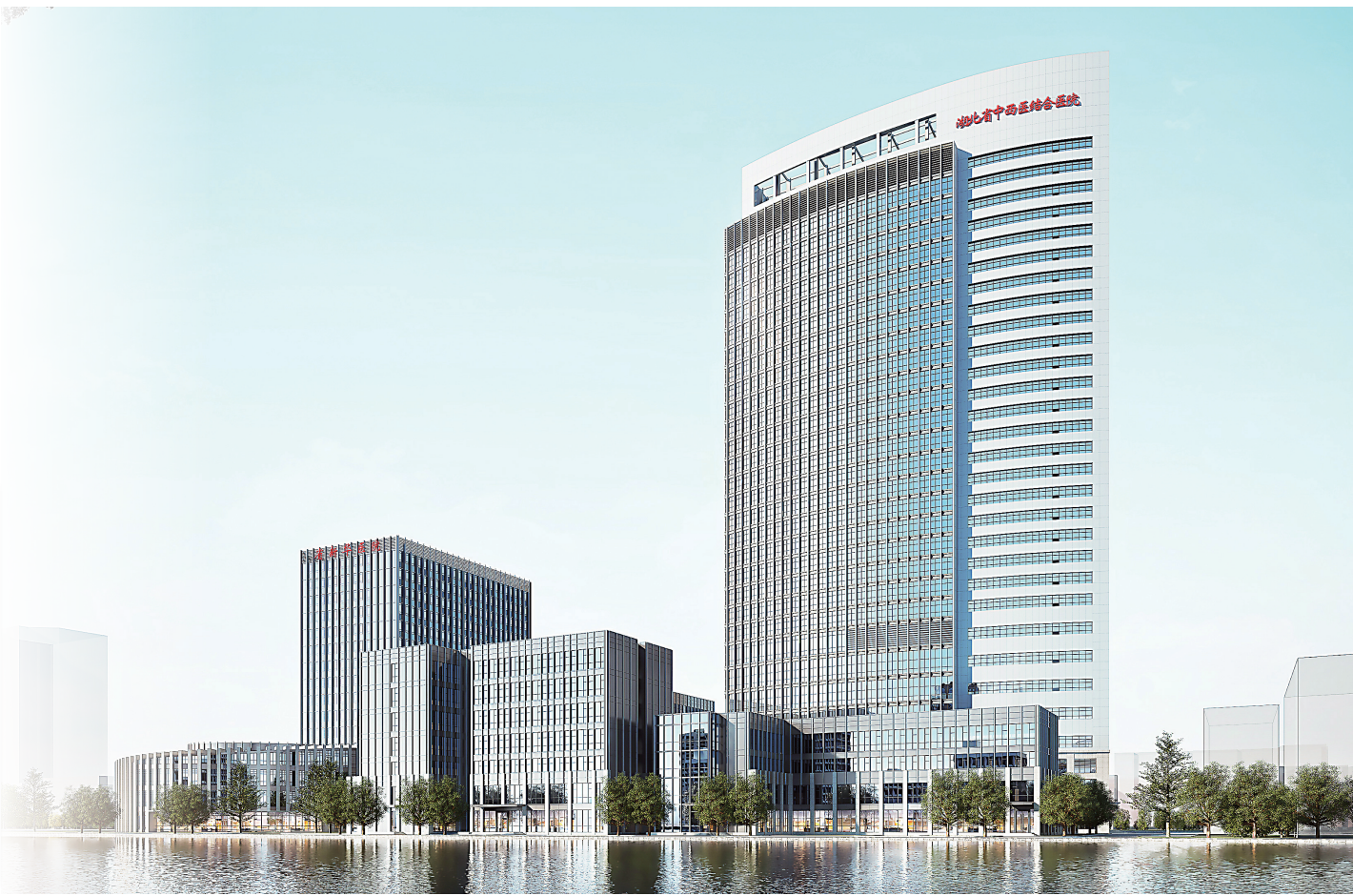
湖北省中西医结合医院大楼成为汉口菱角湖边的地标建筑。
