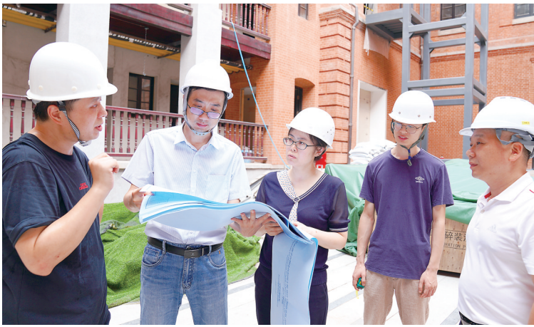
审计人员在汉口历史风貌区改造项目实施施工现场查看建设情况。
