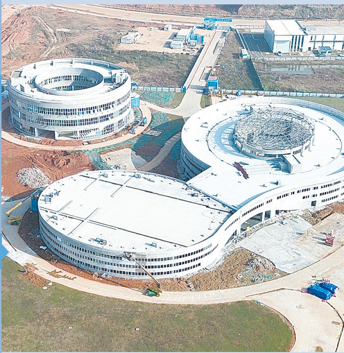
武汉新城首个大科学装置——深部岩土工程扰动模拟设施国家重大科技基础设施（简称地镜设施）项目建设现场。
